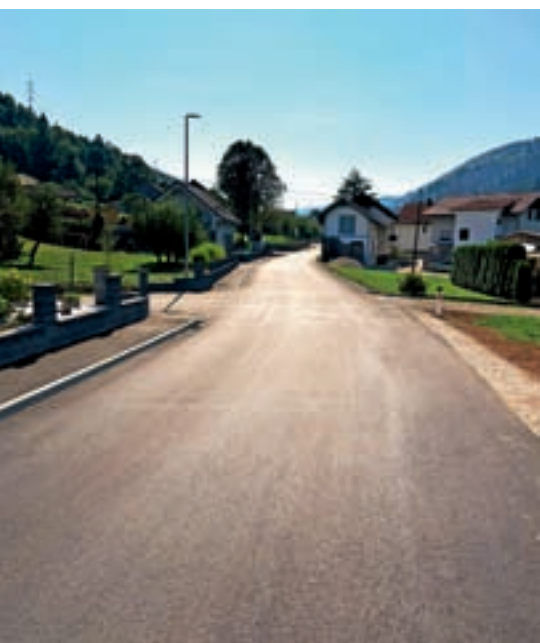
Gradnja pločnika na cesti Pod griči Foto: arhiv občine
